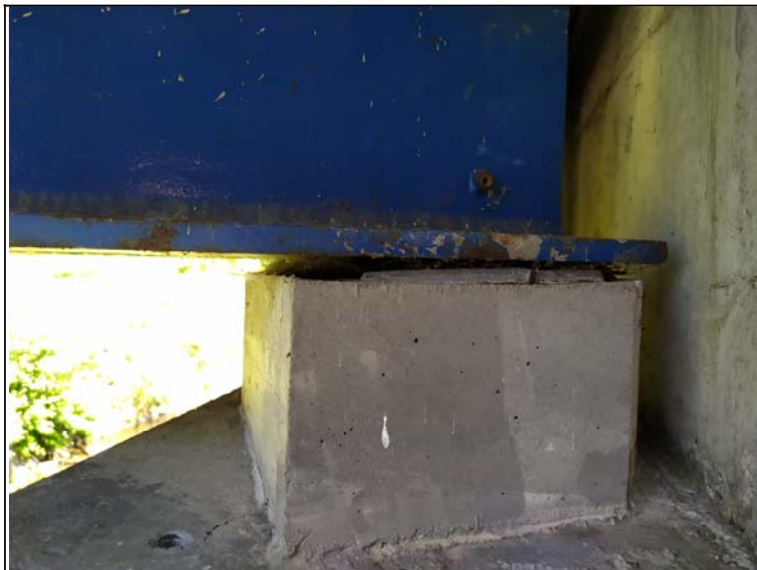
Uložení nosníku na opěře 1
